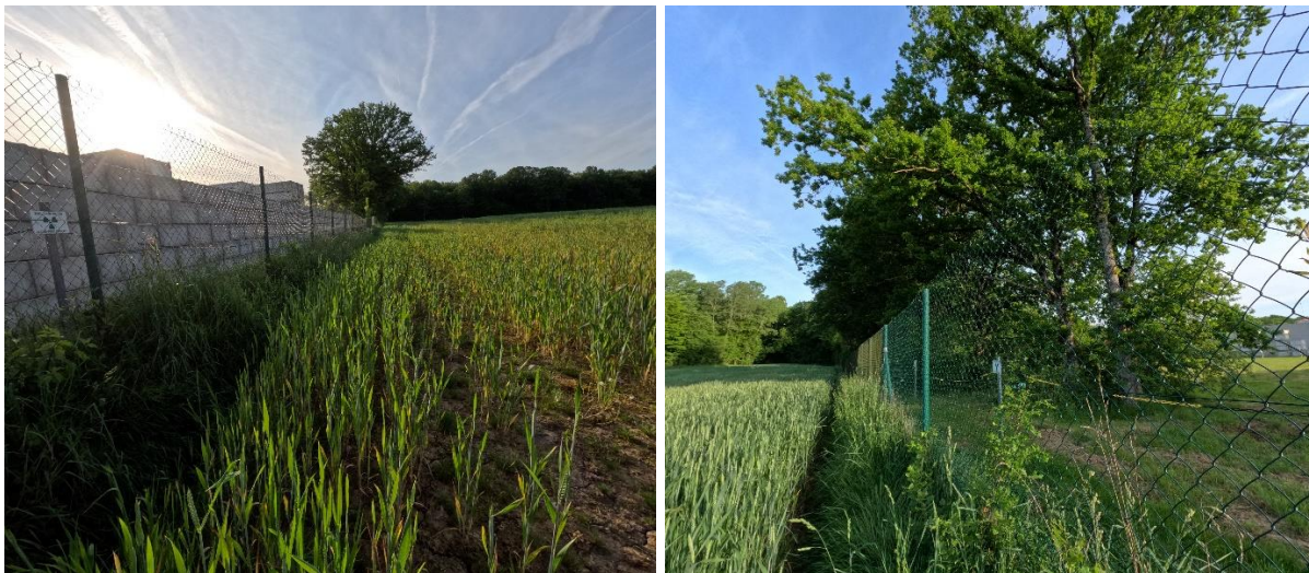
Figure 50 : Tronçon 2 de la haie vive remplacé par des blocs béton
