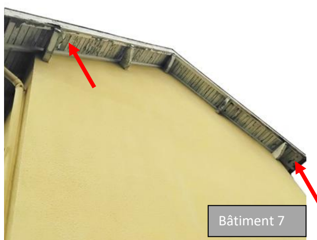
Figure 8 : Photographies des interstices pouvant être utilisés par les chiroptères pour accéder à la toiture
