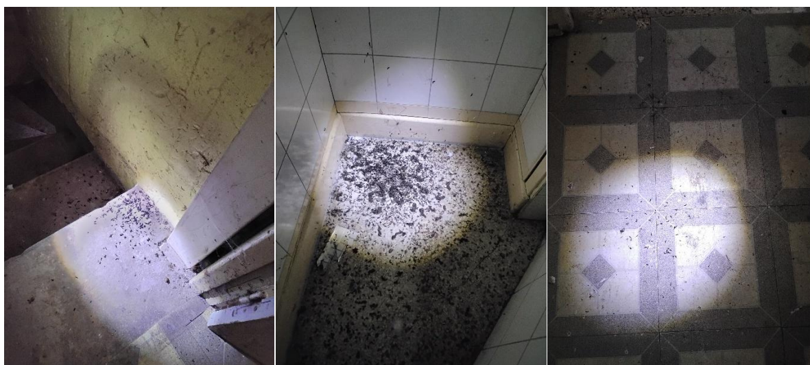
Photographie 7 : indice de présence des chiroptères au sein du bâtiment
