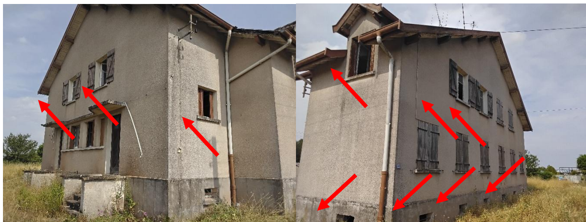
Photographie 8 : ouvertures du bâtiment
