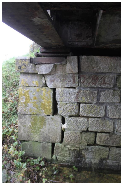
Figure 2 : exemple de disjointements observés sur la pile Est du pont sur la commune de Sampigny
