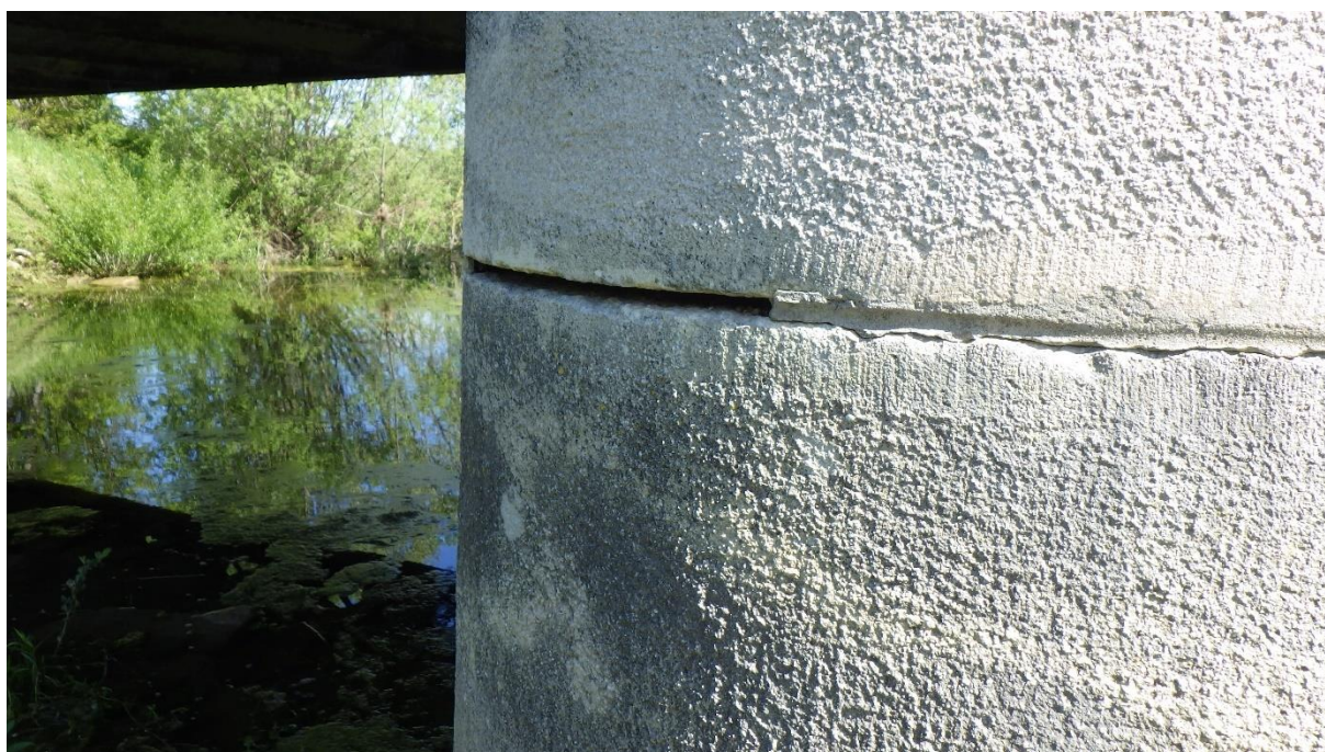
Figure 5 : disjointement de la culée ouest du pont de décharge de Mécrin
