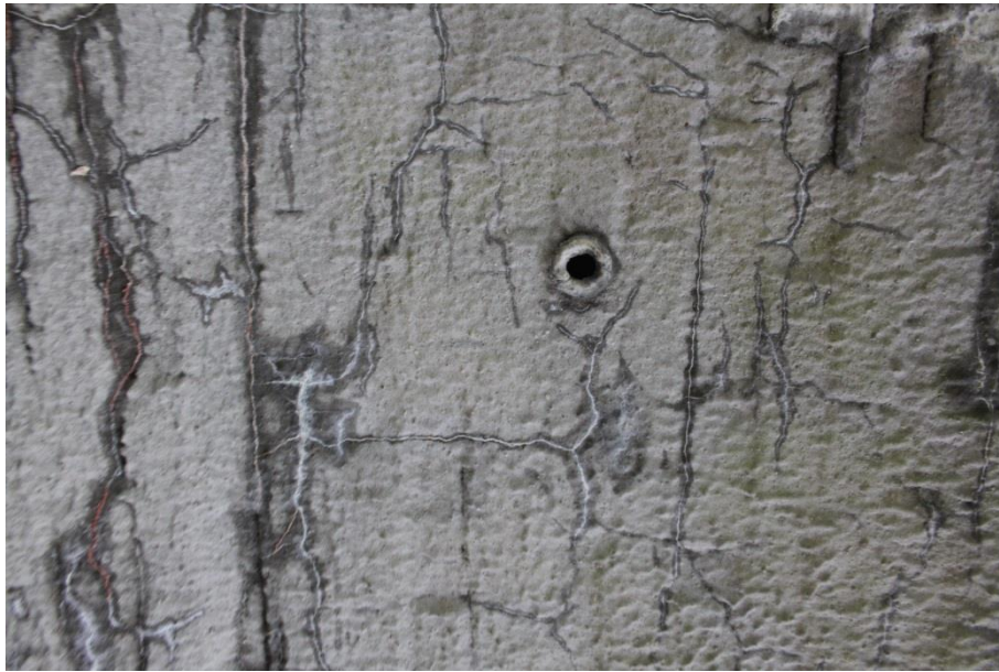
Figure 1 : exemple de drain observé sous le tablier
