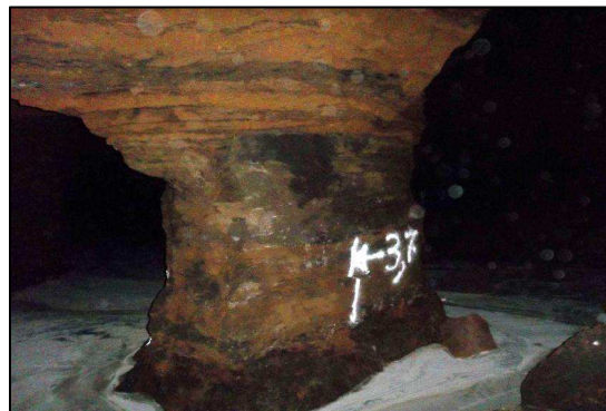
Arrivée de coulis à la base du pilier
