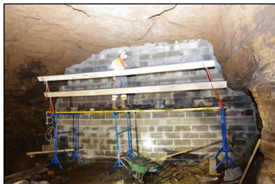
Montage d'un barrage
