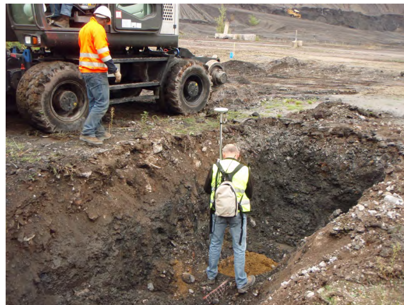
Fouilles pour localisation des réseaux de conduites
