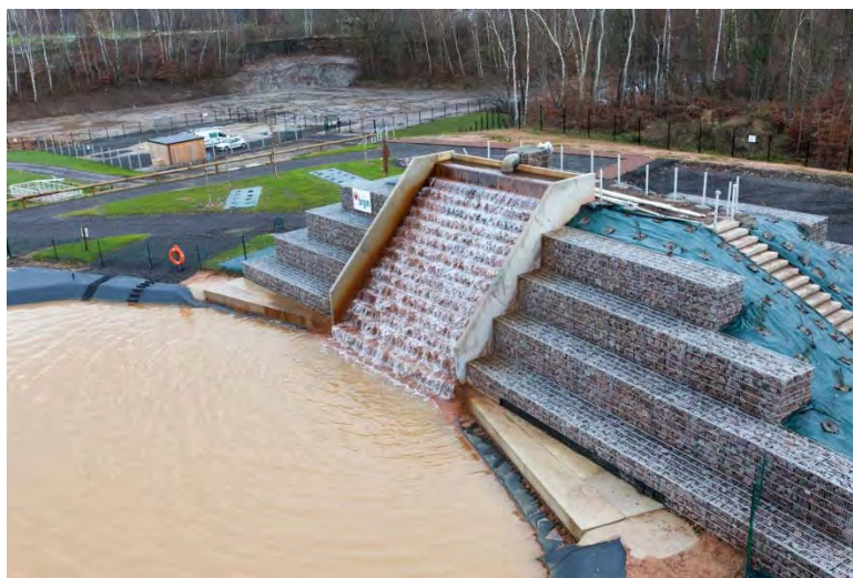
Cascade d'oxygénation et bassin de décantation
