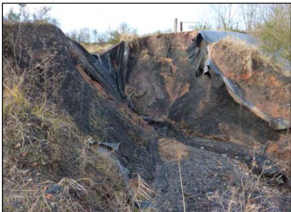
Dégradation du raccordement au bassin de décantation
