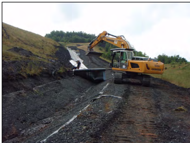
Pose de la géomembrane
