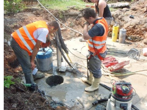
Carottage dans la dalle en tête de puits
