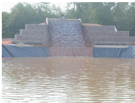
Essai de pompage et mise en eau des bassins
