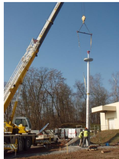
Mise en place du mât
