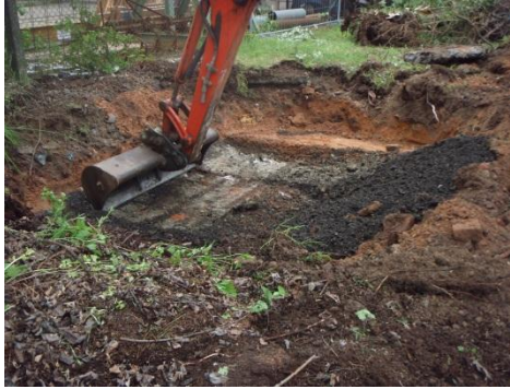
Décapage de la dalle de fermeture en tête de puits
