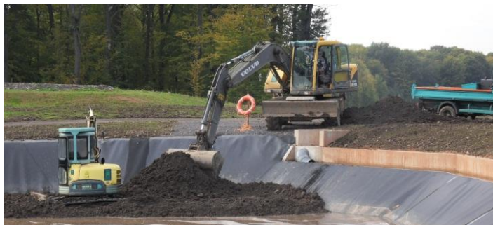
Mise en place de la terre végétale dans les lagunes
