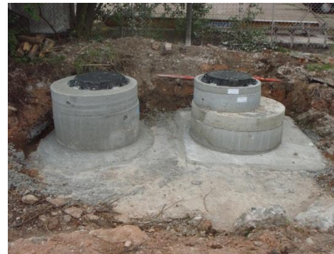
Regards d'accès aux deux dispositifs de mesure du niveau de remblai
