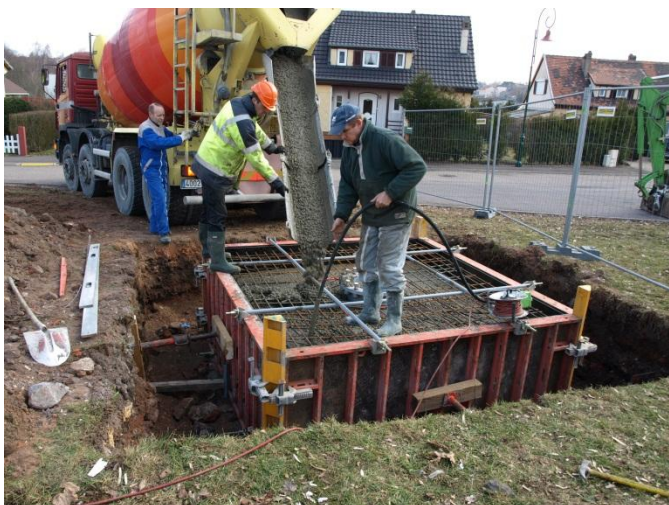
Confection d'un socle support du mât
