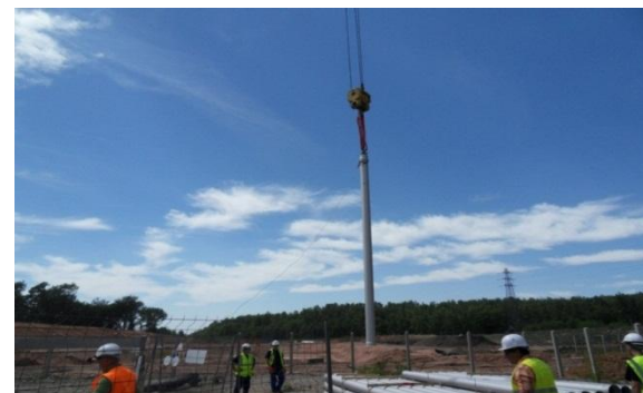
Mise en place de la colonne et du groupe de pompage
