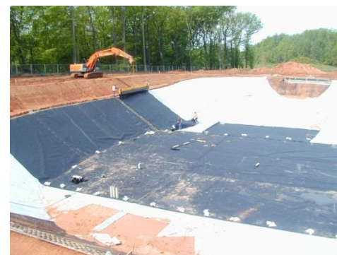
Etanchéification des bassins
