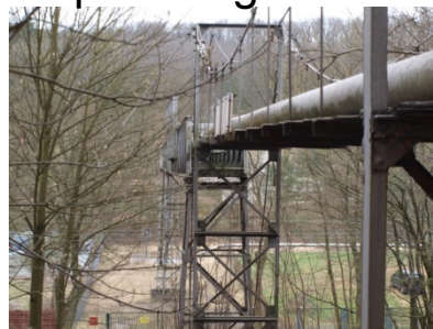
Mauvais état général et forte oxydation des haubans de la passerelle de Winborn
