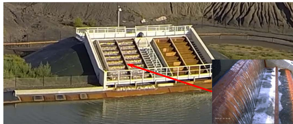
Cascade d'oxygénation avec marches creuses
