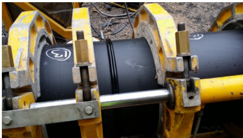
Assemblage de la conduite par thermo-soudage
