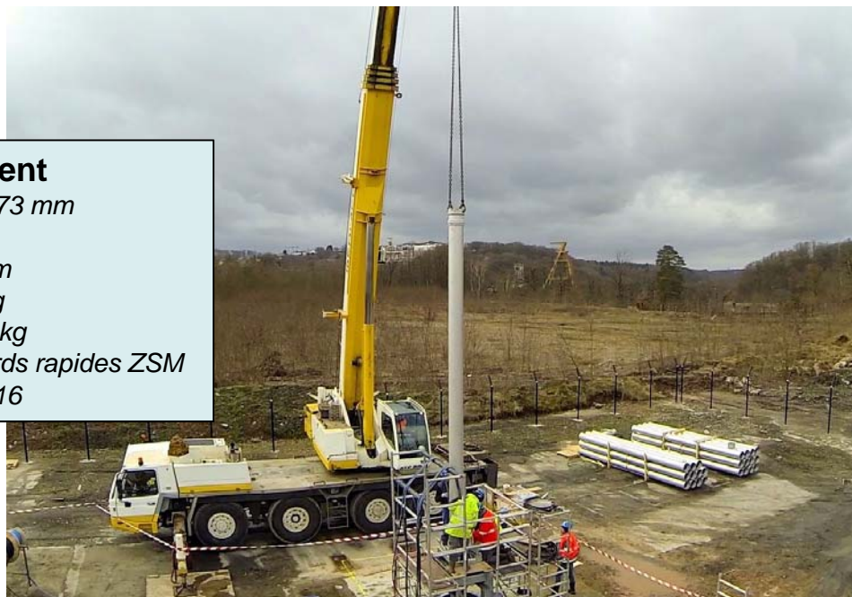
Mise en place de la colonne de refoulement avec le groupe de pompage immergée
