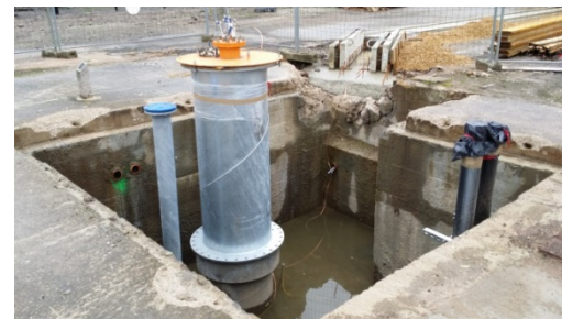
Fosse en tête de puits avec rehausse du tubing et avant comblement
