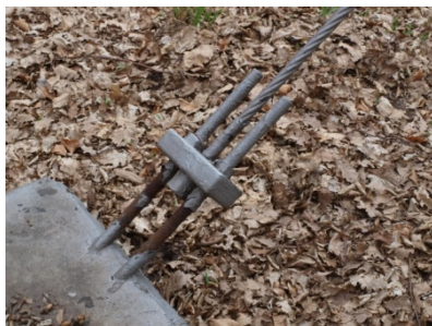
Mauvais état général et forte oxydation des haubans de la passerelle de Winborn
