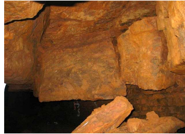
Fracturation du toit
