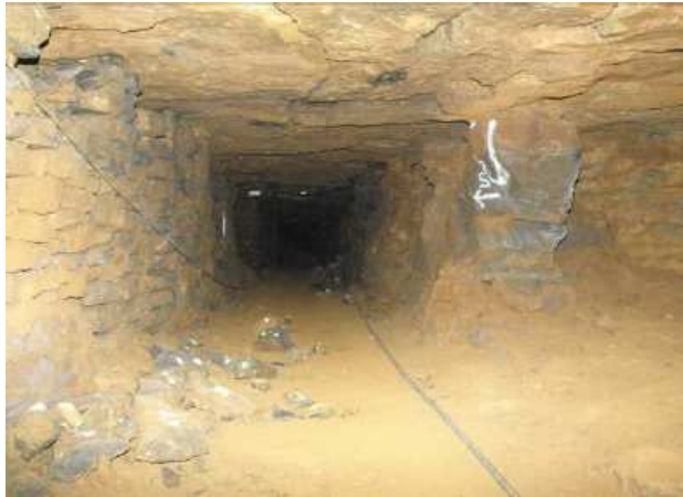
Piliers de st érole délités et piliers soumis à de fortes contraintes
