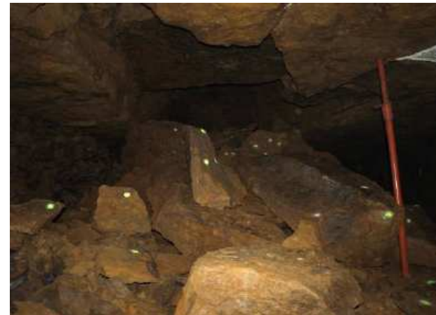
Importantes chutes de toit (éboulements)
