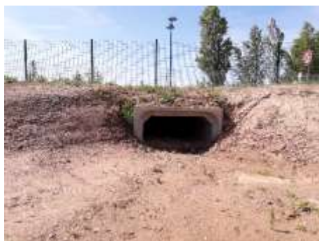
Photographie 2 et suivante : vue du passage inférieur pour la petite faune terrestre installée par l'EMS.
