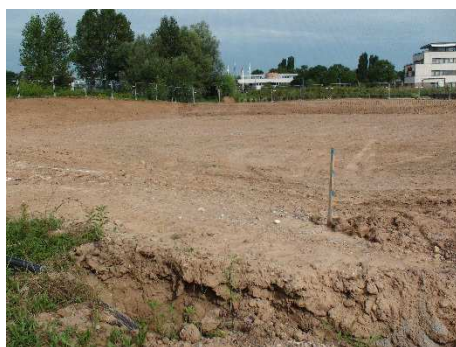
Photographie 2: la dépression compensatoire avant dépôt de la couche d'étanchéité (argile).
